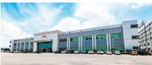
3 Завод в г. Цзюцзян (2 млн. комплектов кондиционеров)
